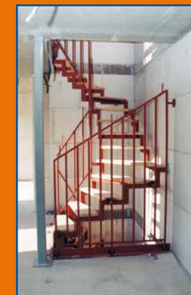
Treppe im Rohbau
